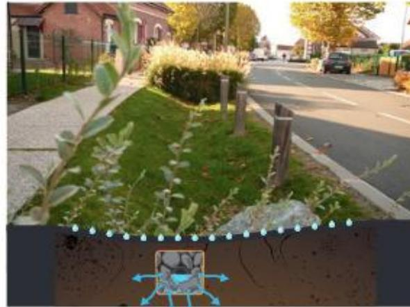
Noue avec tranchée d'infiltration
